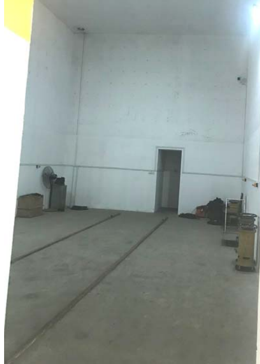
探伤室内部照片
