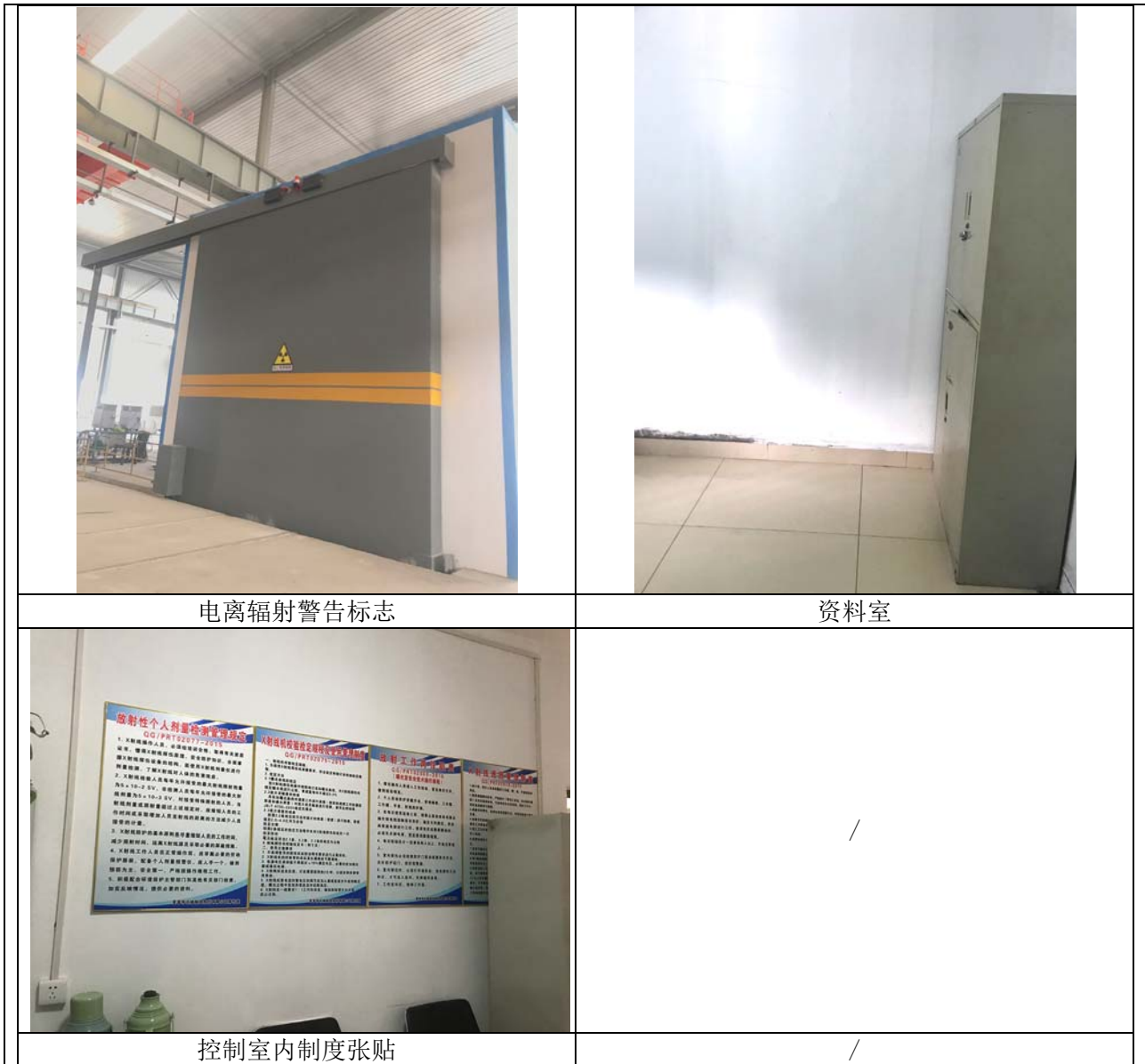
图 2-6 探伤室现状及周边照片
